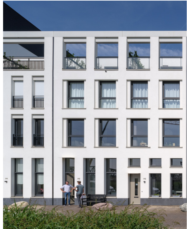
gevelaanzicht blok F
